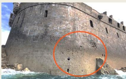
Nous avons constaté une dégradation sur le rempart Nord Ouest, avec l'apparition d'une fissure dans le four à pain : des travaux à titre conservatoire vont devoir être entrepris dès le printemps prochain.
